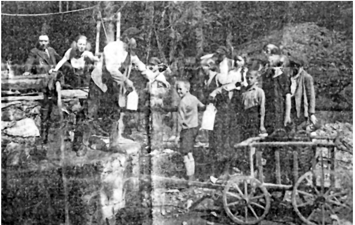
Wasserholen von der neuen sprudelnden Heilquelle
