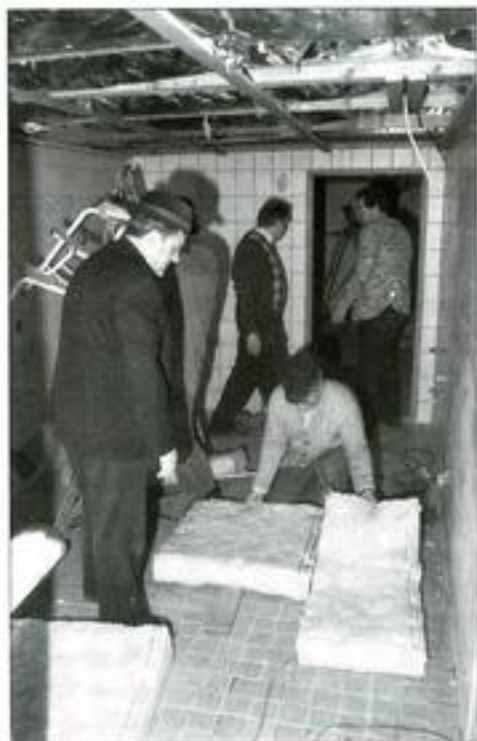
Die Damentoiletten unter der Bühne werden gründlich renoviert. In diesem Zusammenhang werden im Jahre 1984 drei Duschen u. a. für die Ferienlager eingebaut.
