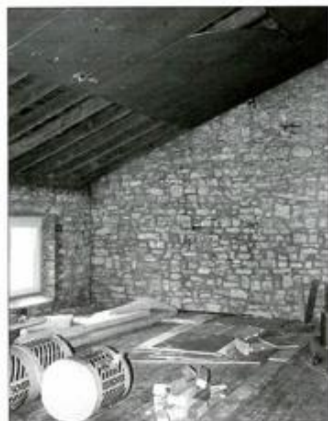
Beginn der Bauarbeiten für die neuen Toiletten auf der Bühne im Königssaal im Jahre 1998
