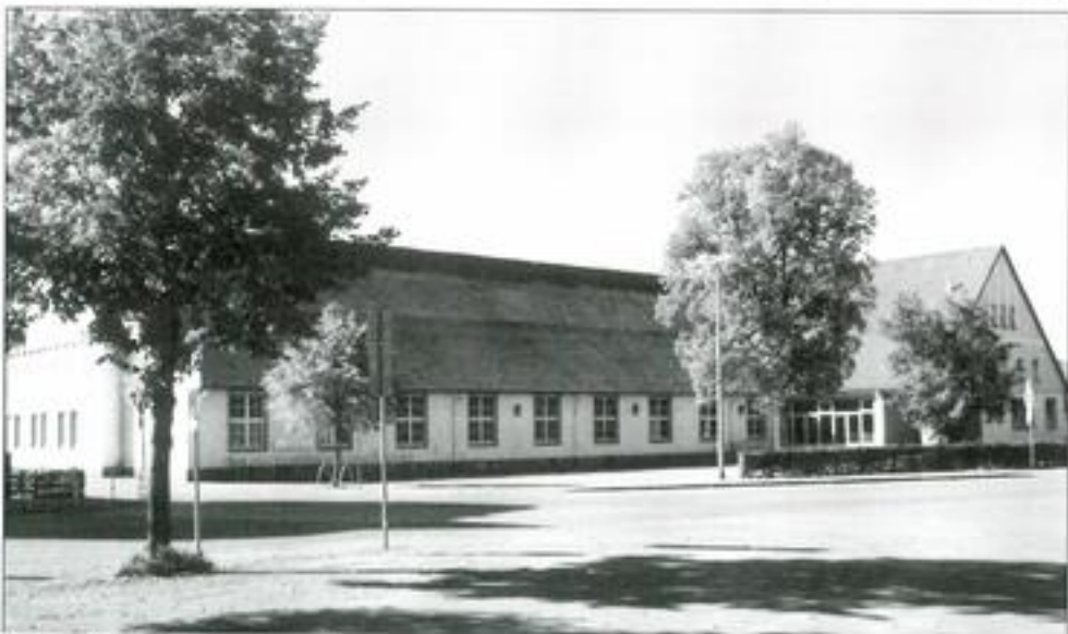
Fertigstellung des Erweiterungsbau
