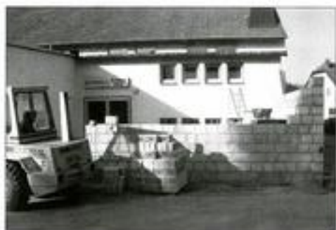
Toilettenanbau der Süd-/Ostseite einschließlich neuem Eingang zum Kleinen Festsaal im Jahre 1991
