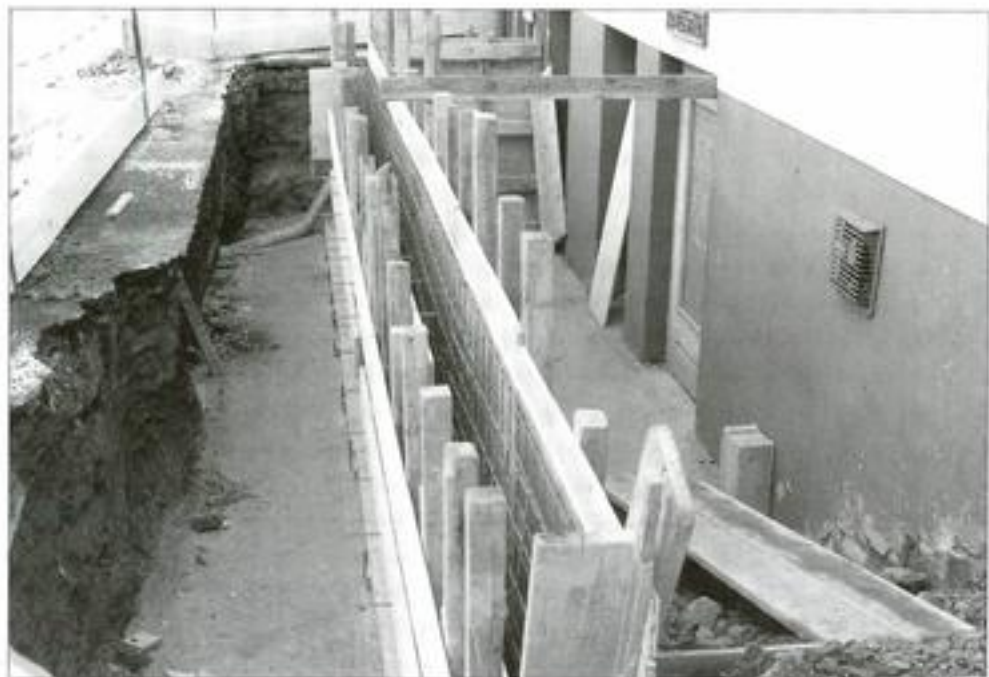
Die Stützmauer sowie der Zugang zum Schießraum und den öffentlichen Toiletten werden im Jahre 1985 erneuert.
