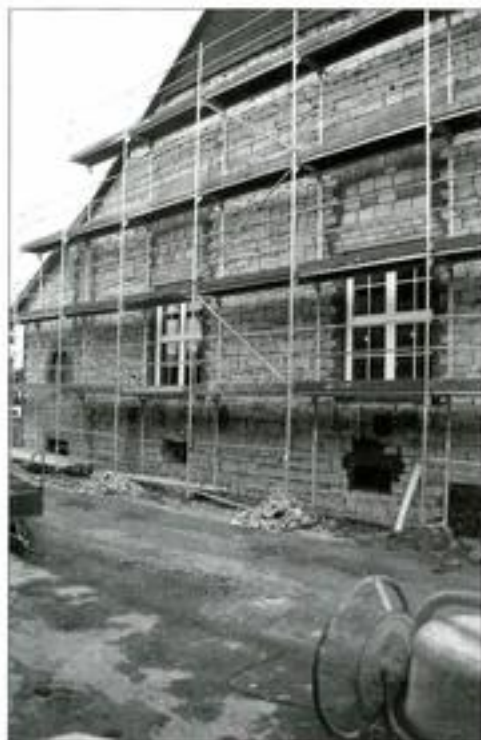
Die Giebelwand der Westseite wird im Jahre 1990 gründlich renoviert, u. a. werden neue, verkleinerte Kunststofffenster eingebaut, die Wand verputzt und Münchener Rauputz aufgetragen.
