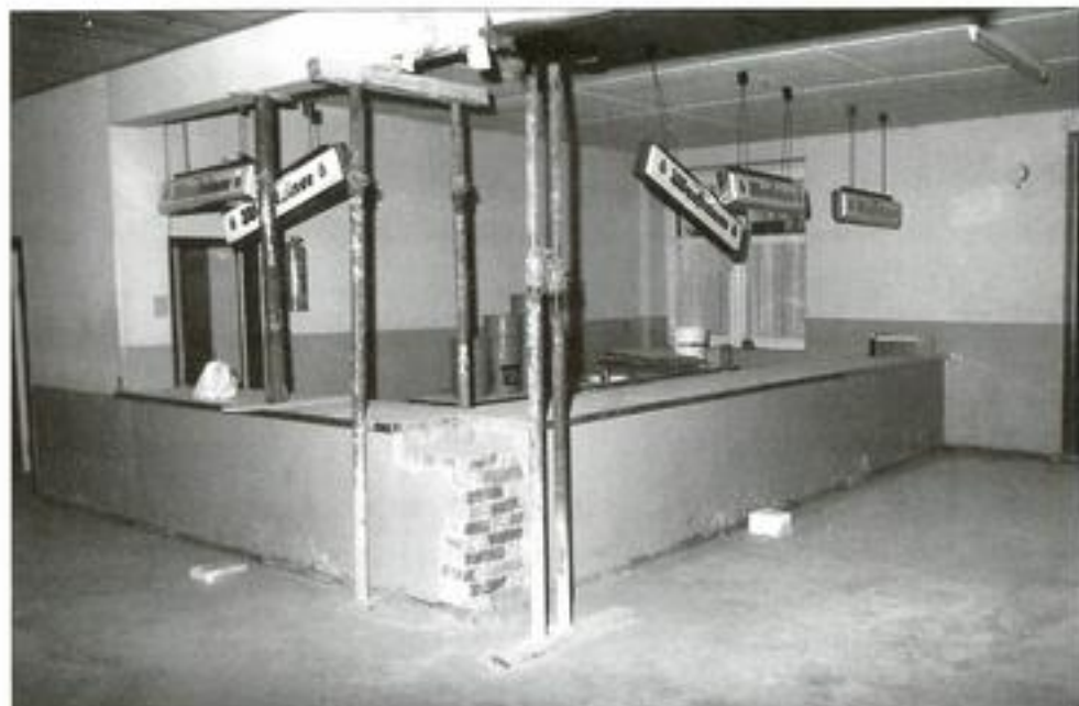
Die Ecktheke wird renoviert und bekommt eine neue Edelstahlabdeckung im Jahre 1987.
