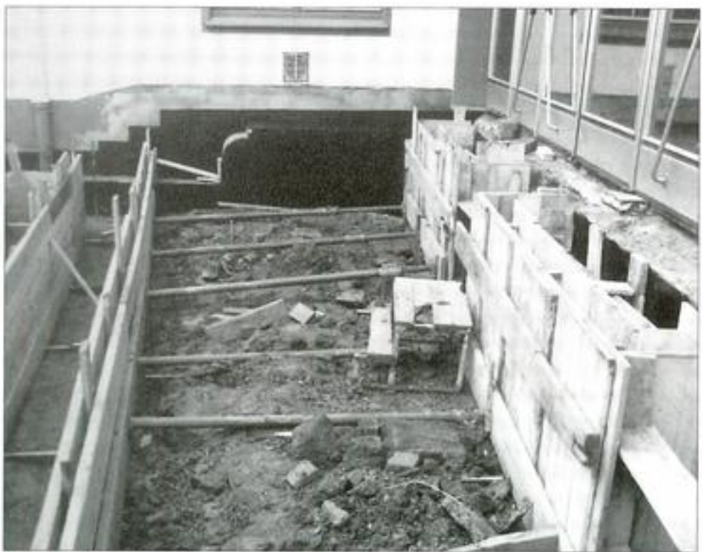
Erneuerung der Außentreppe am Haupteingang mit behindertengerechtem Aufstieg im Jahre 1986
