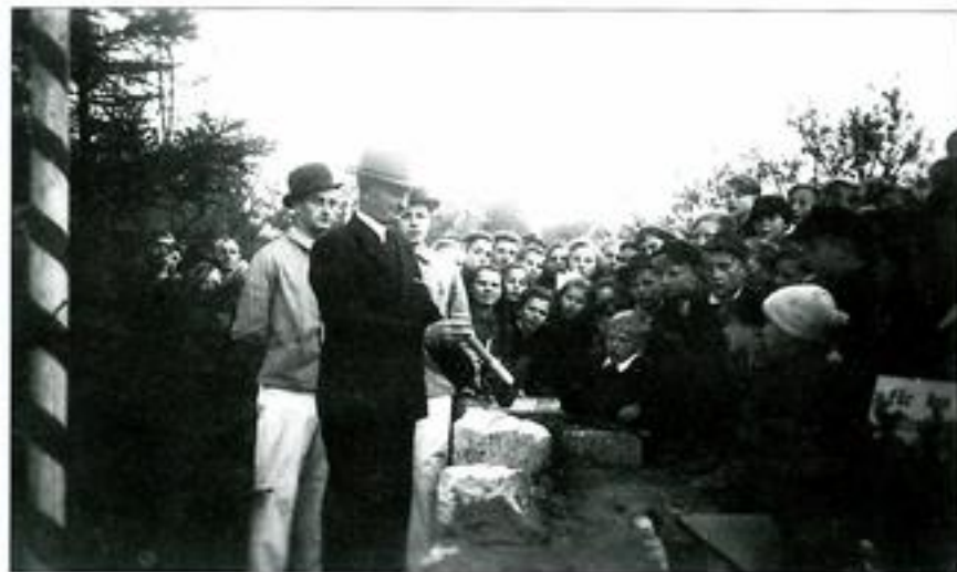
Grundsteinlegung im Jahre 1949 durch Fritz Hoppe, Engelbert Hoppe und Alfons Schulte
