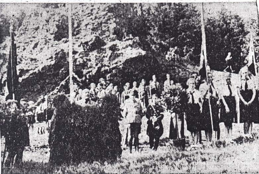
Den ersten Spatenstich zum neuen HJ-Heim auf der Külbe vollzog Landrat Dr. Teipel. Unser Bild zeigt einen Ausschnitt während der Feierlichkeiten.
